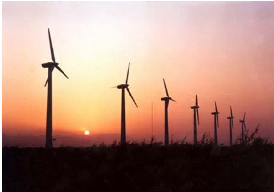
Central Eoloeléctrica La Venta Oaxaca, México
